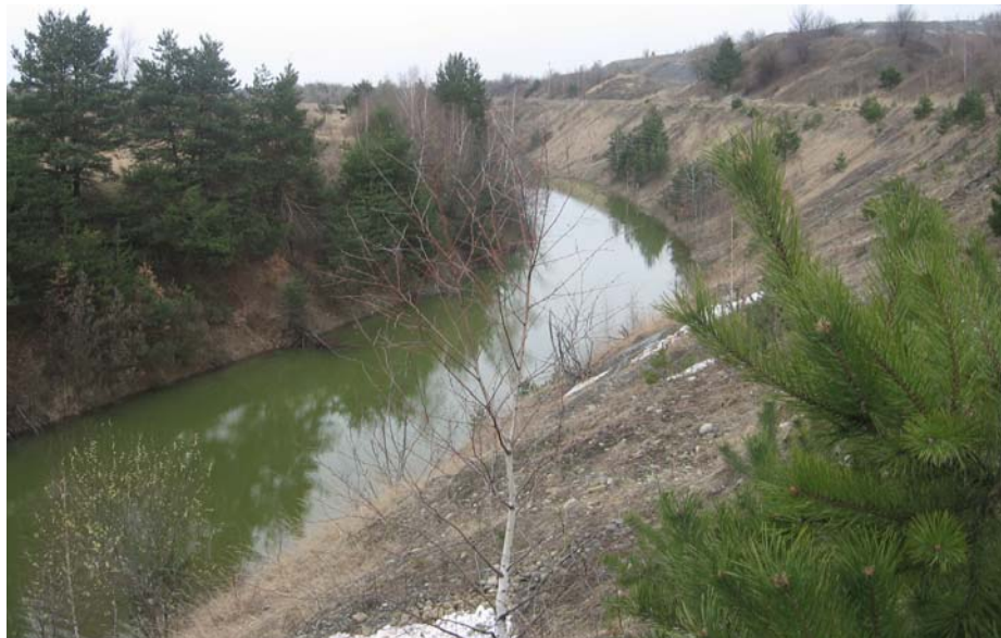
Рис.1 Вигляд дренажної траншеї на даний час
