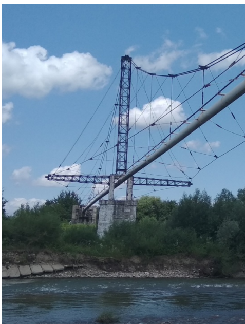
Рис. 1. Загальний вигляд несучої системи висячого трубопроводу на ділянці надземного переходу через водну перешкоду
