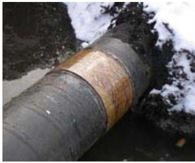
Рис. 1.3. Загальний вигляд намотаної муфти на дефект
