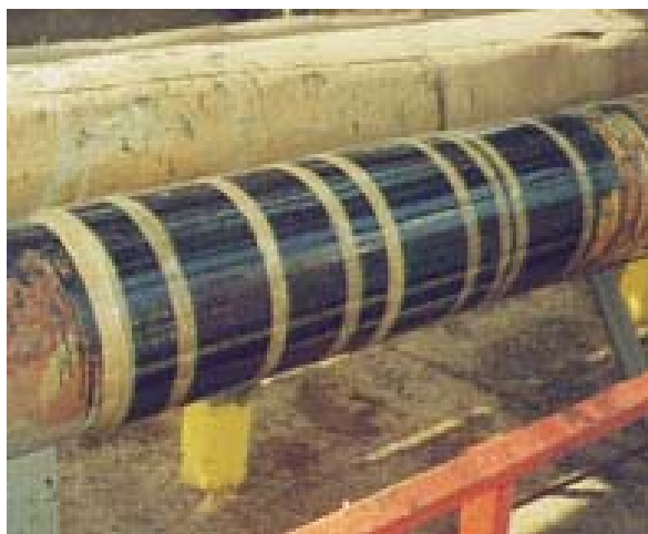
Рис. 1.5. Встановлена стрічка ГАРС
